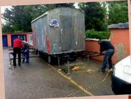
Jetzt konnte der Zusammenbau beginnen. Es wurden eine zusätzliche Tür und ein neues Fenster eingebaut und ein Balkon angebaut, ebenso bekam der Bauwagen einen neuen Boden aus Siebdruckplatten, belegt mit einem PVC Bodenbelag.
